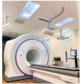
図4. 天窓照明（青空照明）が設置された治療室
